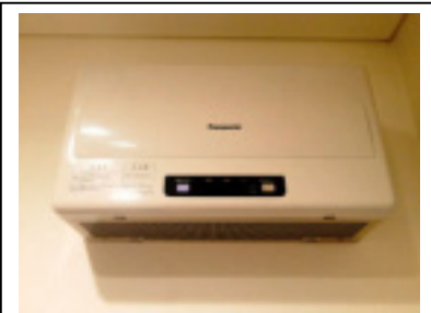
パワーコンディショナ設置
